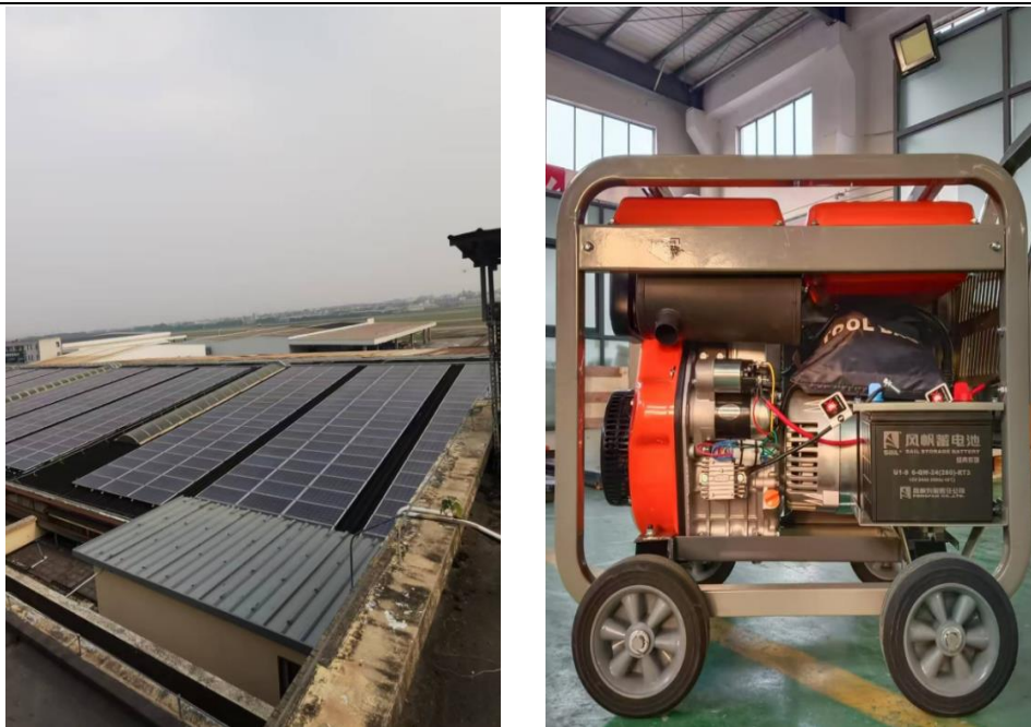
图 2.27 光伏发电板和柴油发电机
