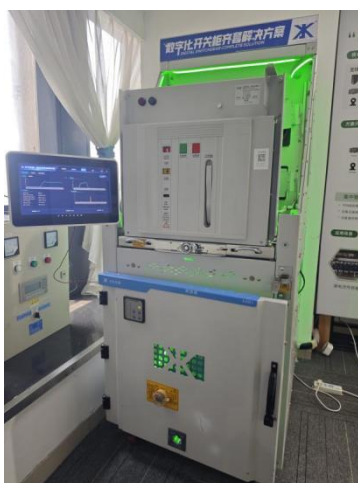
图 2.25 高压断路器健康管理系统实际运行图
