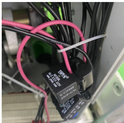
图 2.5 开启式电流传感器安装
