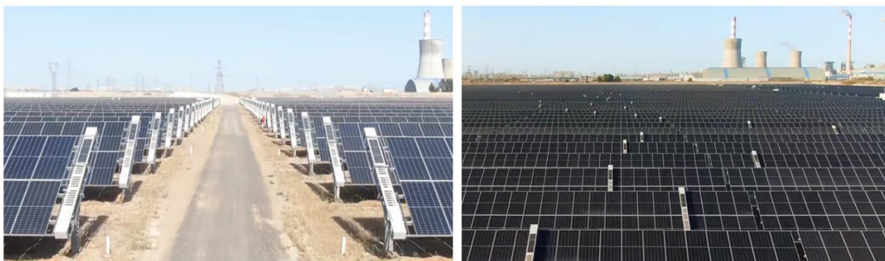
图 2.1 配备挂式光伏清洁机器人的集中式光伏电站
