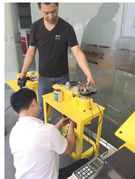
图 2.8 设备安装调试
